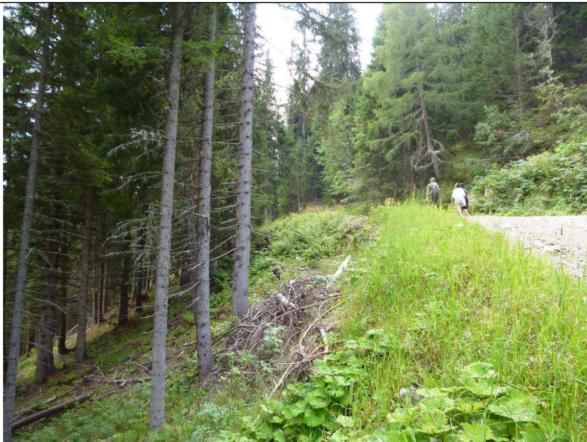
Foto 11 - L'attuale scarpata di valle del tornante 4 non presenta controindicazioni all'erezione della terra armata per l'ampliamento del tornante.
