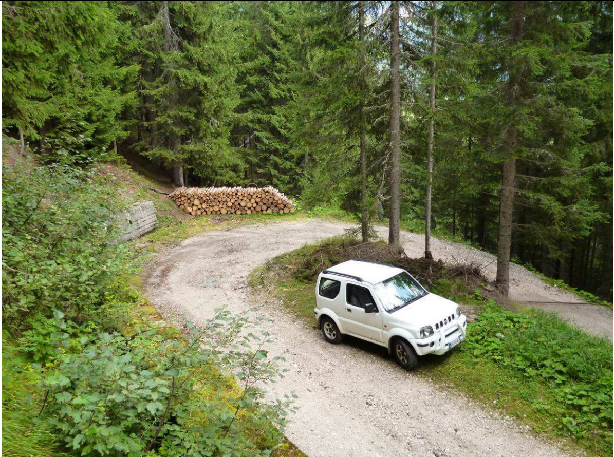
Foto 9 - Tornante 3. Evidente il raggio di curvatura attuale, insufficiente per i mezzi forestali.
