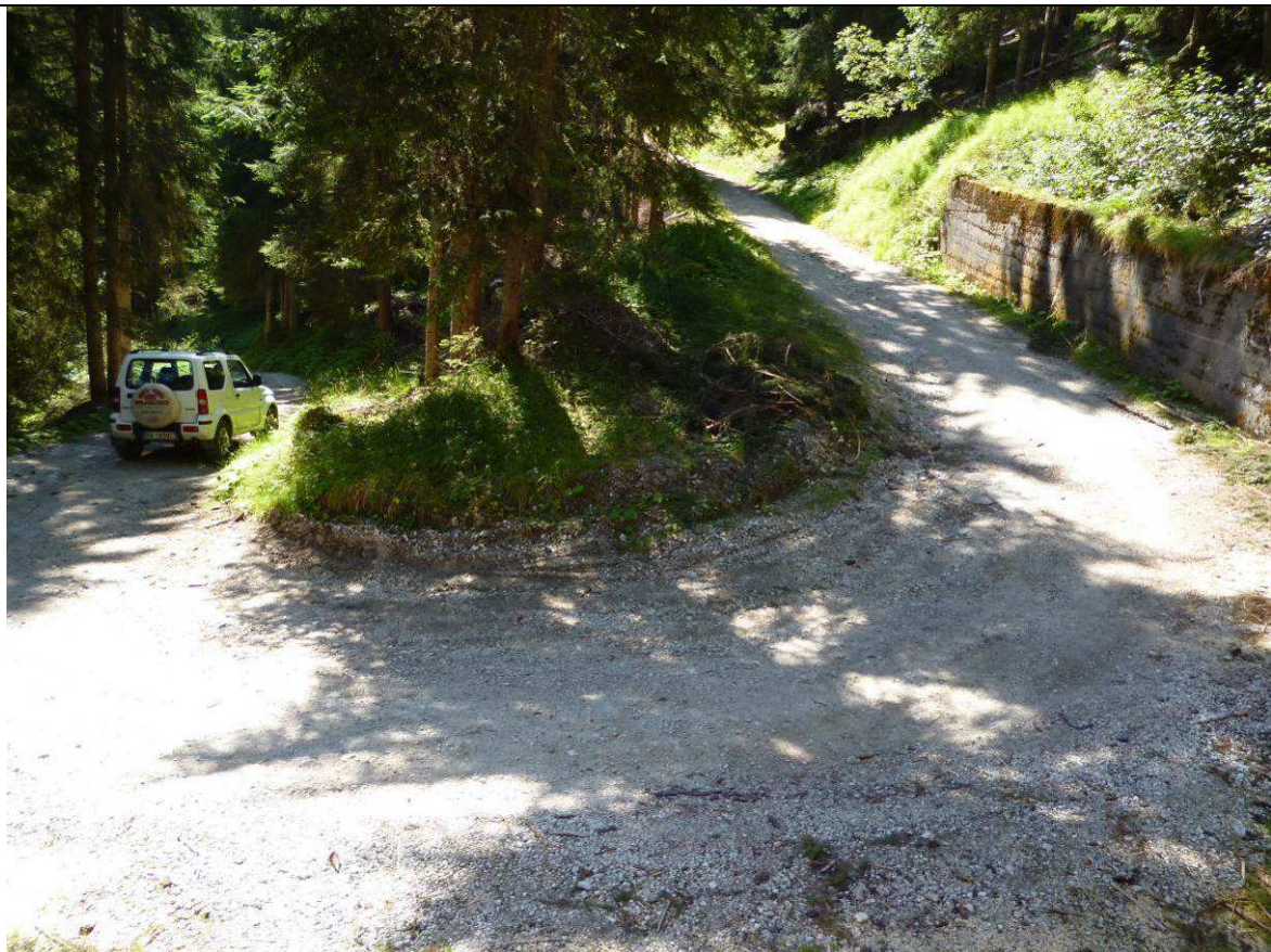
Foto 8 - Tornante 3 - La presenza del muro di contenimento a monte costringe all'ampliamento del tornante verso valle.
