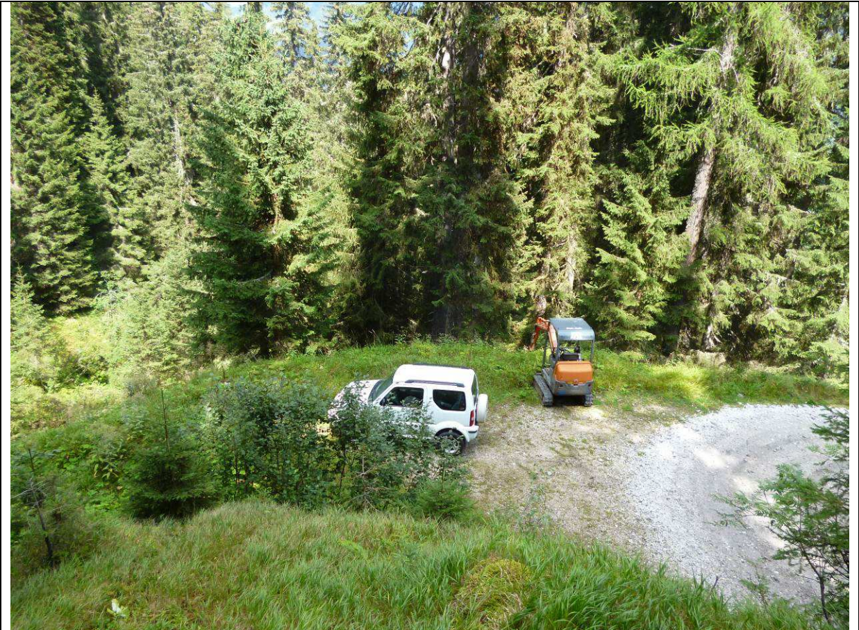
Foto 13 - Tornante 5. L'ampliamento del tornante implica la costruzione di una terra rinforzata a valle e di una scogliera a monte.
