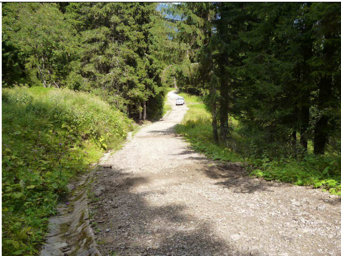
Foto 15 - Tra le sez. 348 e 357 la livelletta si impenna per circa 130 m, superando il 18% consentito dal bando PSR per le strade camionabili. Occorre procedere alla rettifica, ritracciando poco più a valle una nuova carreggiata al 17%. Il guado esistente alla sez. 350 dovrà essere ricostruito.
