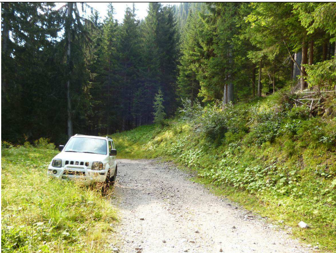
Foto 5 - Tornate 2. La terra armata a monte e le opere di raccolta e scarico delle acque previste consentiranno di rendere il fondo camionabile definitivamente efficiente e agevole da mantenere.
