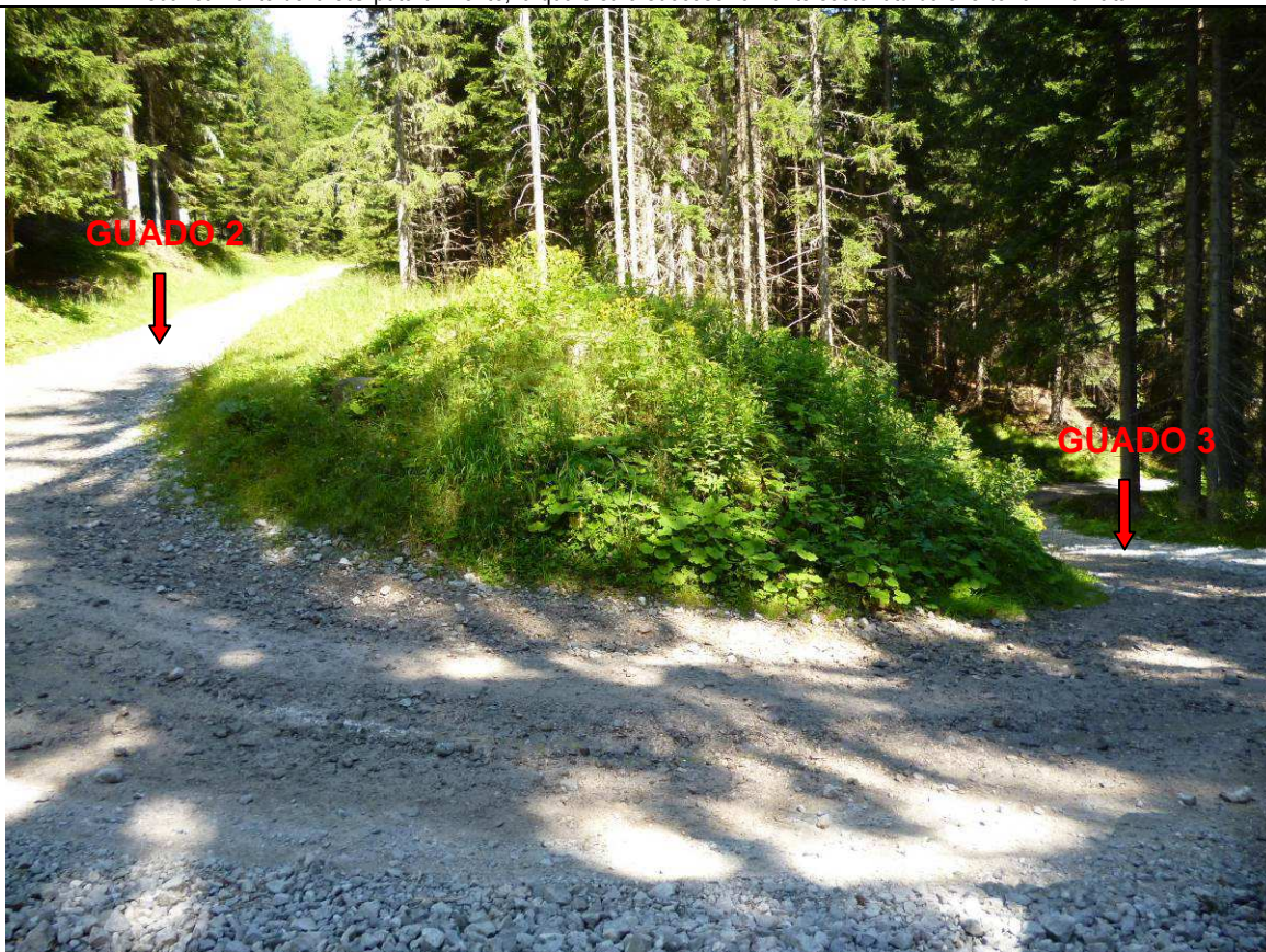
Foto 4 - Tornante 2. Anche questo tornante, pur risultando più ampio del primo e presentando livellette favorevoli, allo stato attuale non raggiunge la soglia di 8 m prevista dal PSR per il parametro del raggio di curvatura della strada camionabile.
