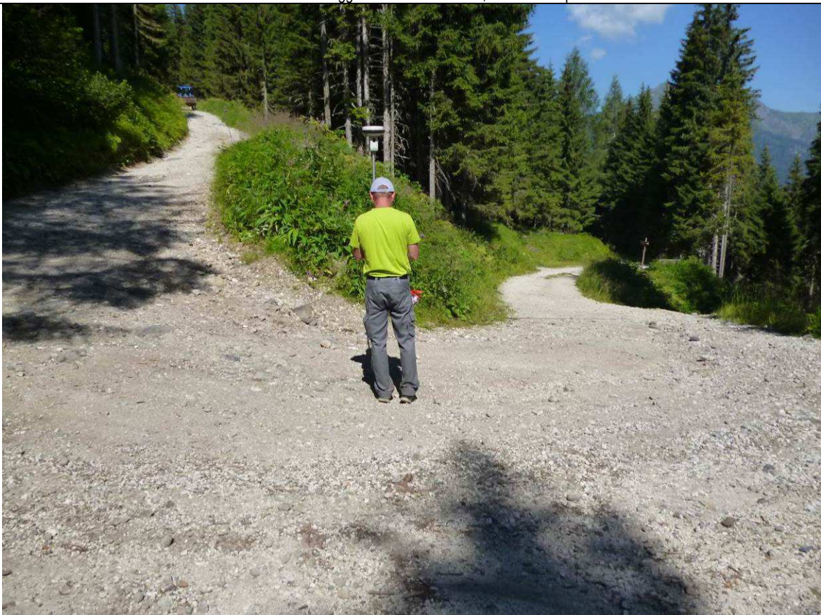
Foto 10 - Tornante 4 (raggio di curvatura inferiore a 4 m). La natura del terreno della scarpata di monte sconsiglia l'allargamento del tornante in sbancamento.
