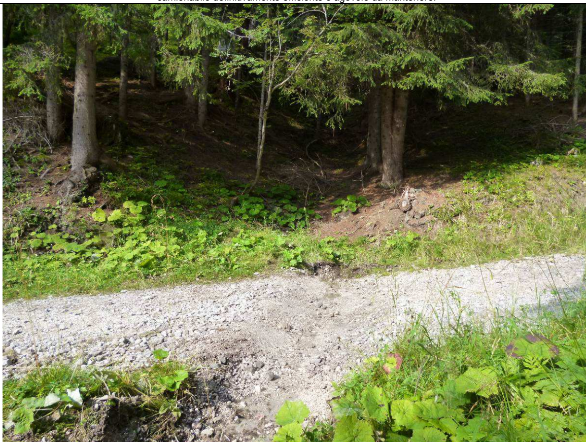
Foto 6- Guado 2 da realizzare a monte del tornante 2. All'altezza del guado converge anche lo scarico della trincea drenante longitudinale fino al guado soprastante già esistente.
